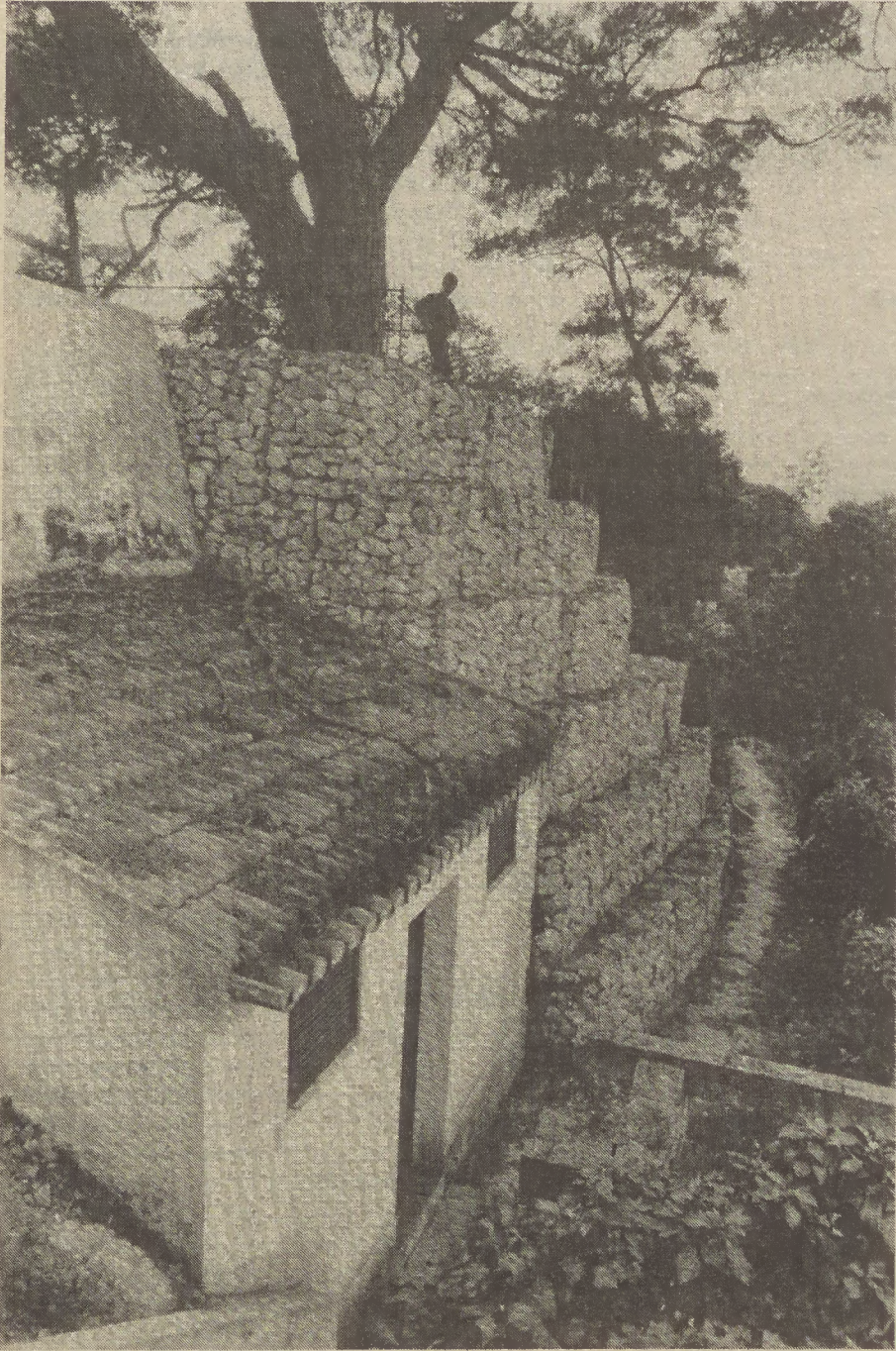
Para salvar este pinheiro, foram gastas 93 toneladas de pedra que o pudessem suportar
