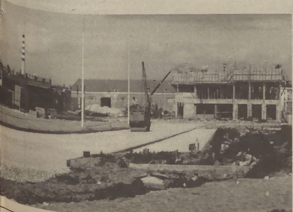
O novo mercado abastecedor (na foto, ainda em acabamento) e as novas oficinas dos T.C.B.
