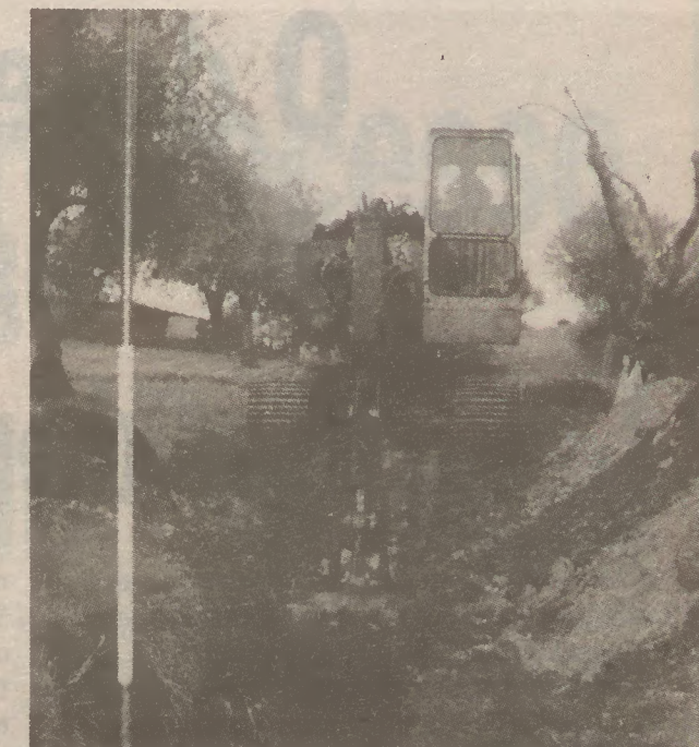
Implantação de infra-estruturas básicas na tapada da fonte do Crespo
