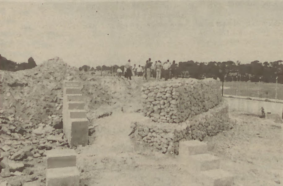
Gabiões de pedra
