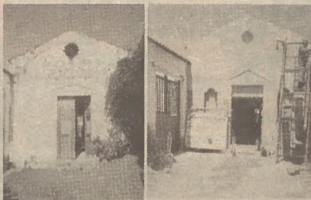
A «Casa dos Bonecos», antes e depois do restauro
