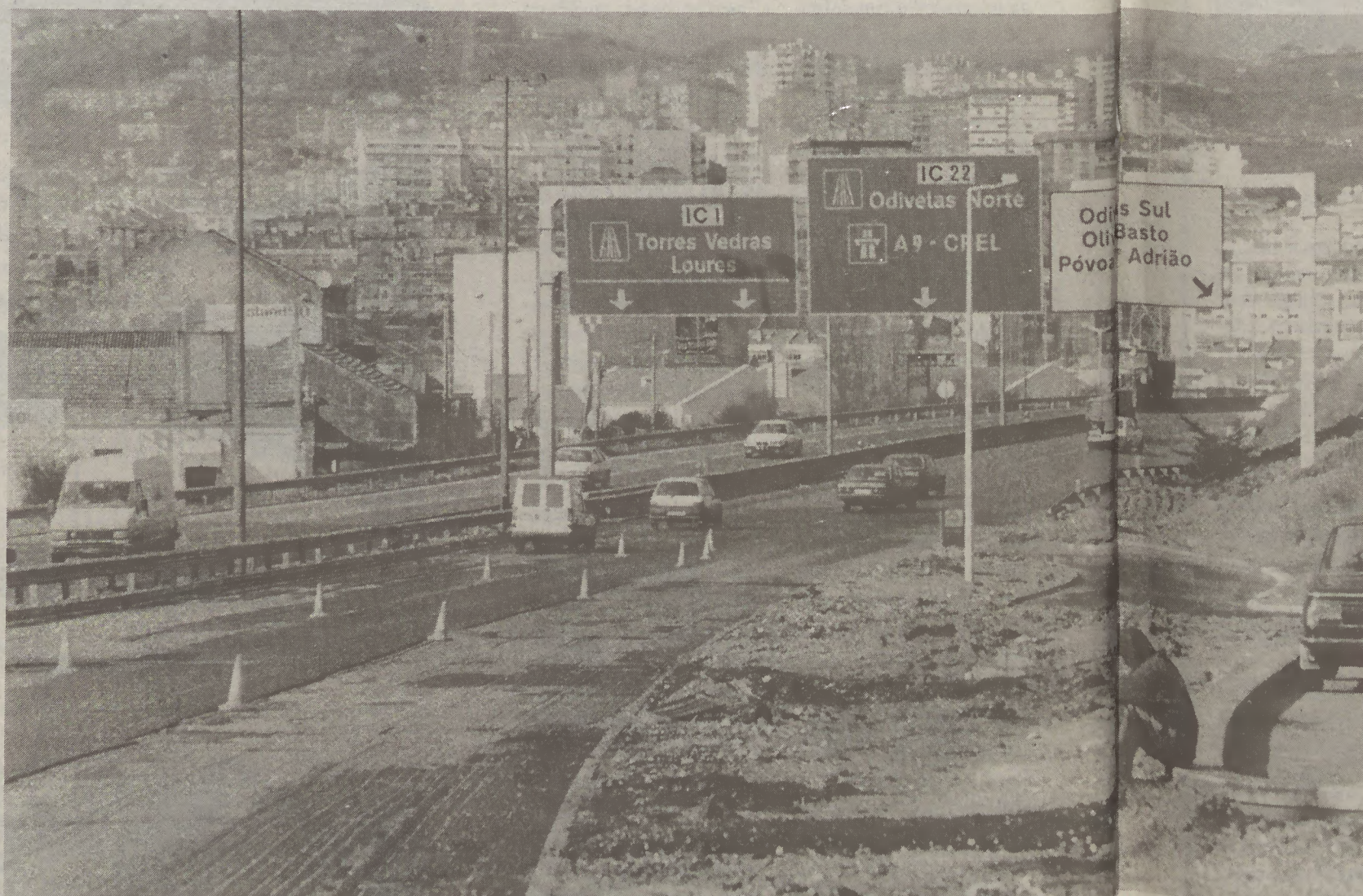
A Cintura Regional Exterior de Lisboa (CREL), que o cavaquismo empoeirou durante anos para depois a construir às três pancadas e à força de rios de dinheiro, ruiu tão fragorosamente que ninguém sabe como andar por lá
