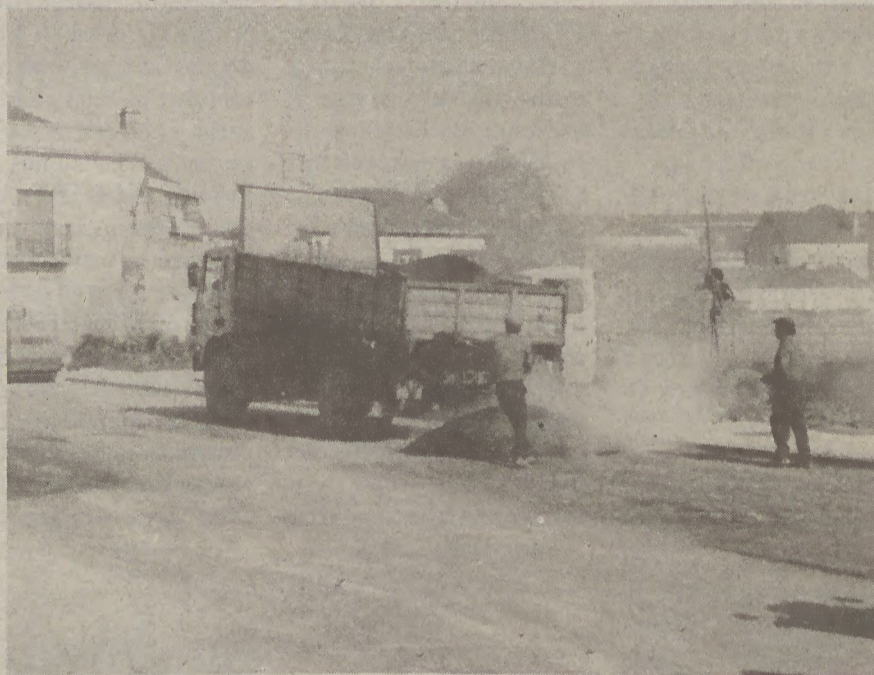
Acudindo à urgência de reparar os pavimentos do concelho degradados pela chuva e as enxurradas, a Câmara Municipal do Barreiro está, desde 1 de Janeiro, a aproveitar todas as «abertas» para intervir
