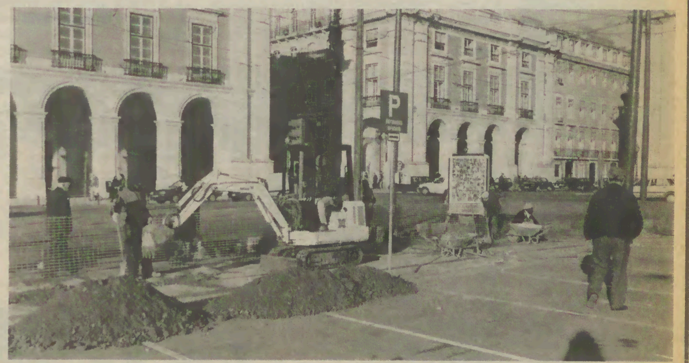
Os trabalhos da primeira fase já começaram, aqui com os operários a iniciar a instalação dos tapumes que, por razões de segurança, irão abrigar as obras de transformação da placa central
