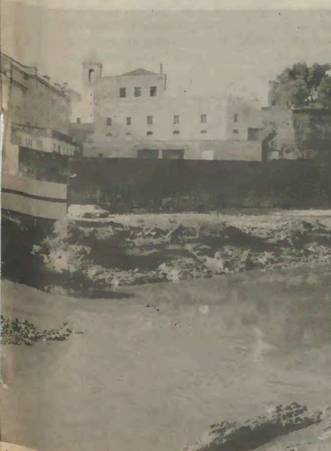
Obra do município de Loures.
