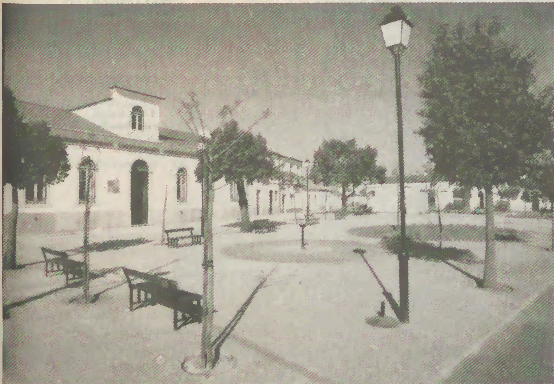
O progresso no concelho de Serpa constrói-se com grandes e pequenas obras, como esta praça na freguesia de Vila Nova de S. Bento
