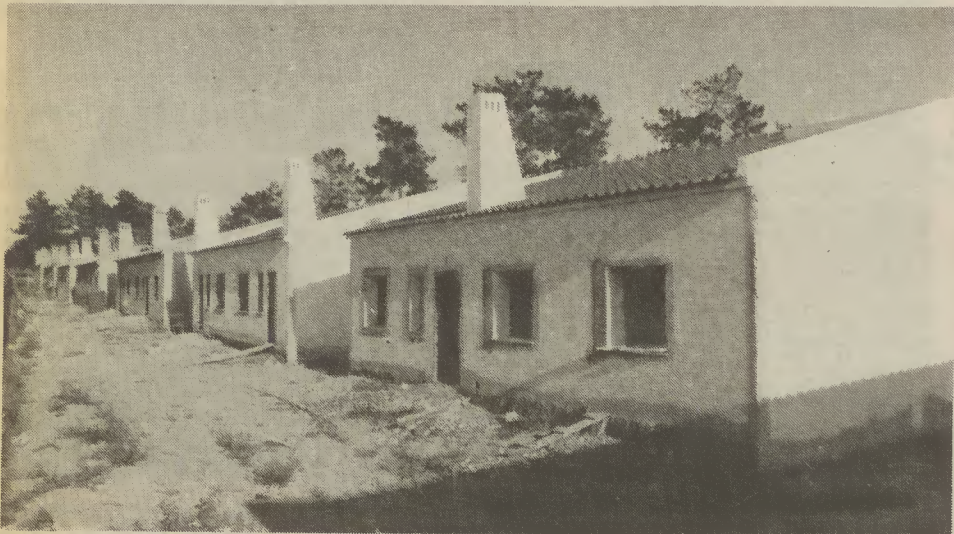
Habitação social – uma obra da Câmara
