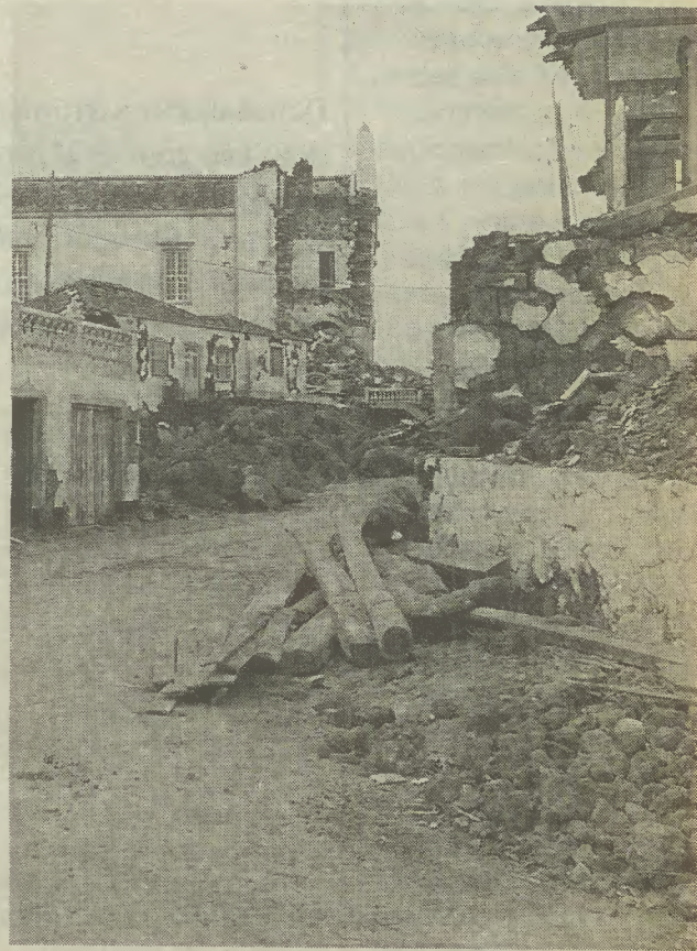
Imagem das destruições do sismo de 1981. Um drama que se repete
