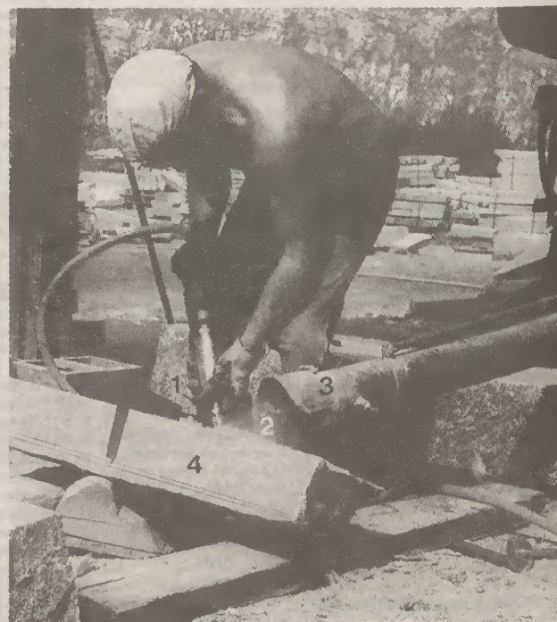
É um trabalho extenuante o da construção civil
