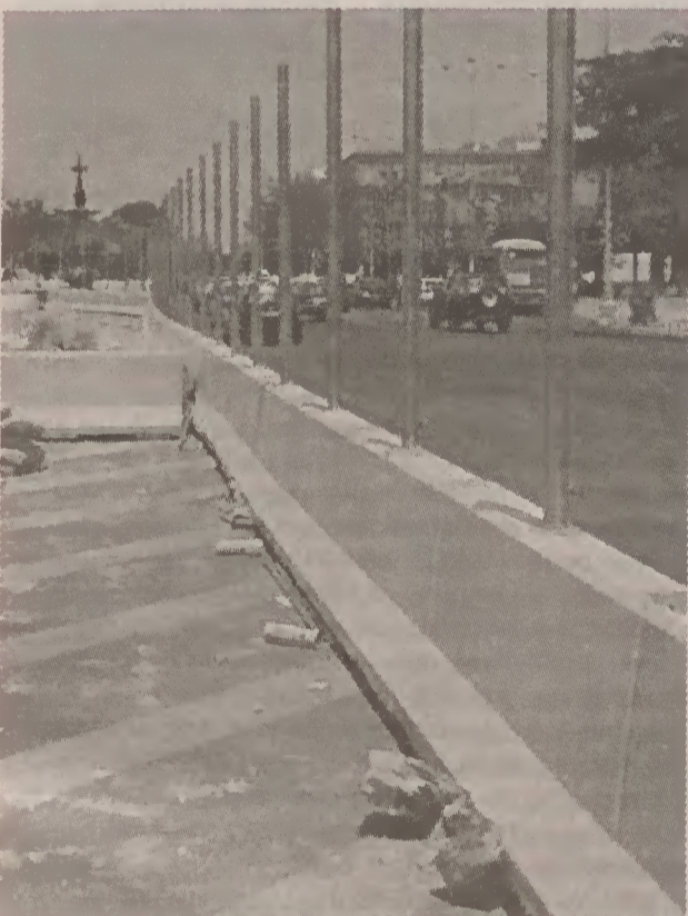
Nas ruas de Sevilha foram erguidas autênticas paredes com blocos de cimento e redes de arame
